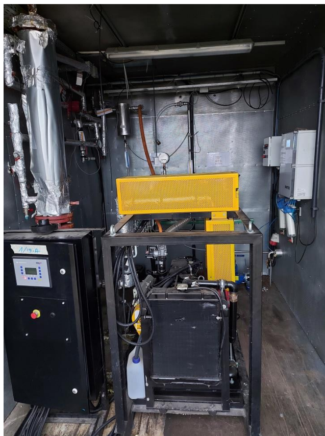
Rys. 20. Agregat kogeneracyjny po optymalizacji - widok szafy sterowniczej (od lewej) i chłodnicy agregatu (od prawej) (fot. Grzegorz Wałowski).
