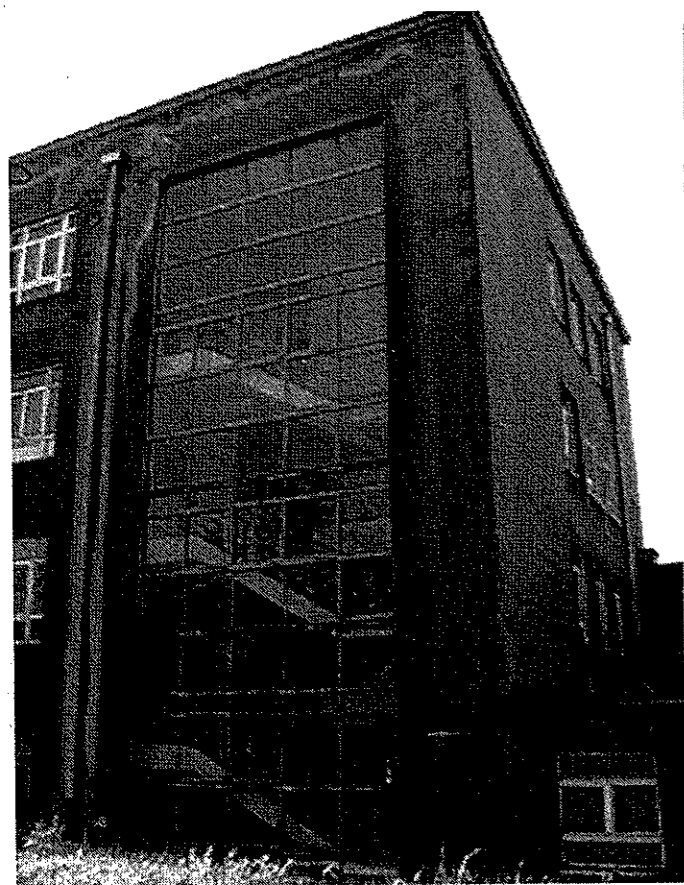
3. PRZESZKLONA KLATKA SCHODOWA
