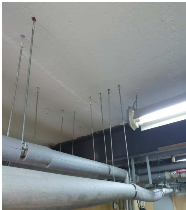
Zawiesia do demontażu na czas montażu podciągów
