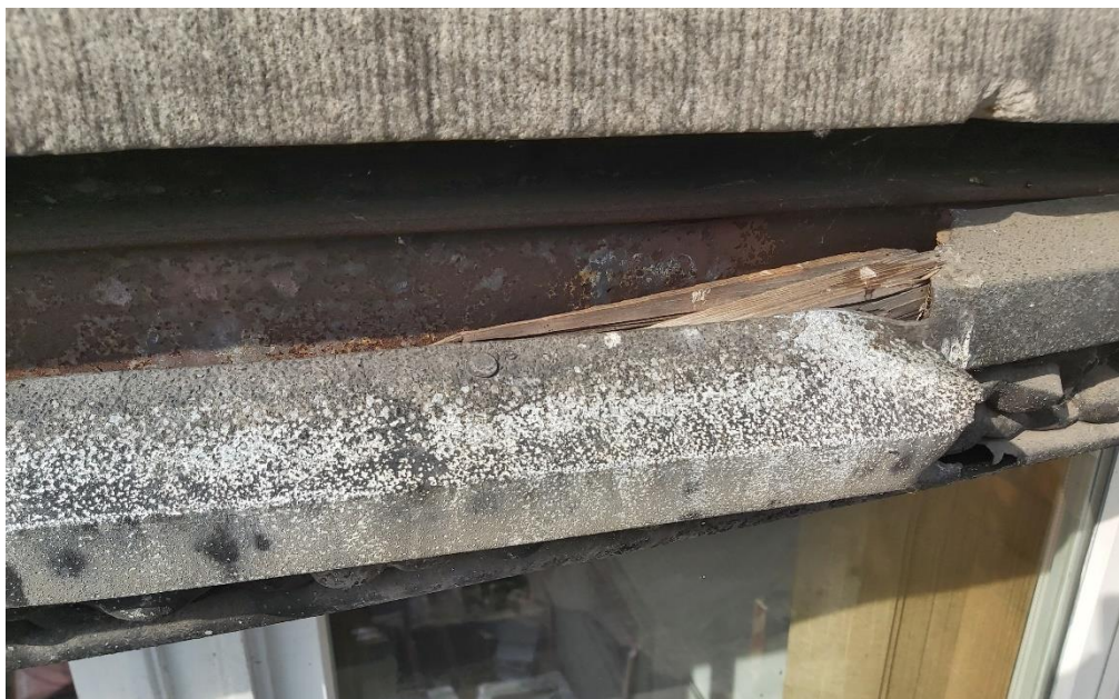
Fot. 46 Dekoracja w nadprożach okien: powtarzający się w różnych oknach motyw różg liktorskich i liści wawrzynu. Wykonana z blachy cynkowo – ołowiowej, pełni funkcję maskownicy dla żelaznej belki konstrukcyjnej.
