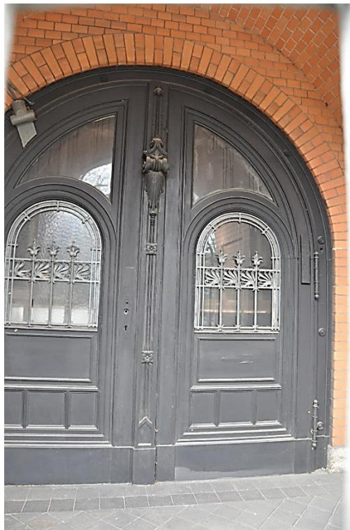
Fot. 62. Drzwi wejściowe do dawnej Królewskiej Szkoły Maszynistów Okrętowych, elewacja frontowa (od strony ul. Pułaskiego).
