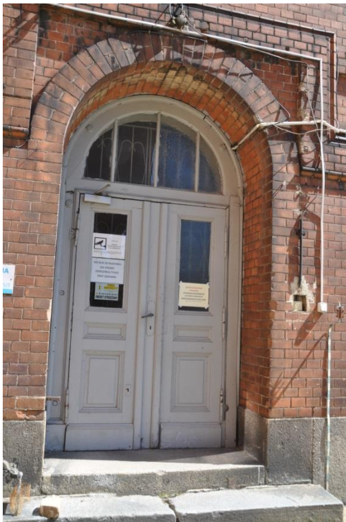
Fot. 68. Elewacja tylna: historyczna stolarka drzwiowa.
