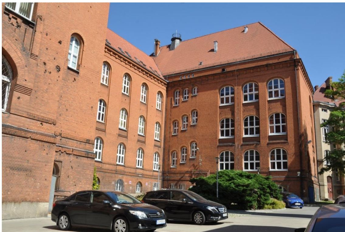
Fot. 15 Elewacja południowo – zachodnia, tylna. Skrzydło od strony południowej.
