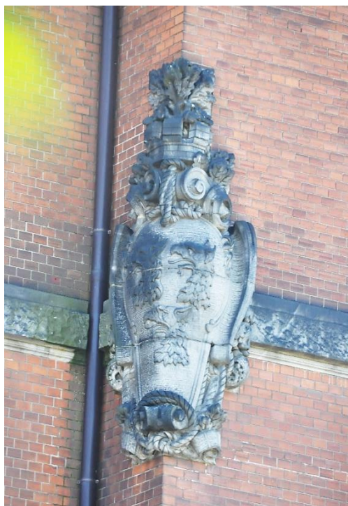
Fot. 30. Kartusz w narożniku ryzalitu na elewacji frontowej: herb Passewalk.
