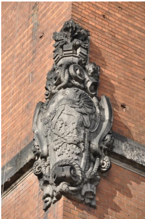
Fot. 26. Kartusz w narożniku ryzalitu na elewacji frontowej: herb Greiswaldu.
