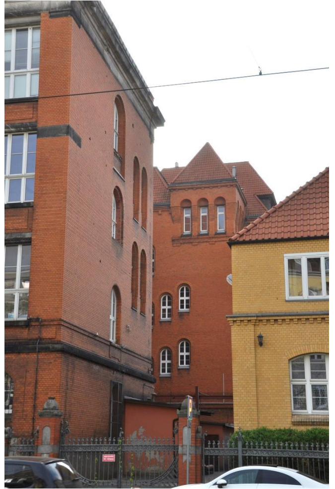
Fot. 12. Elewacja południowo – zachodnia, tylna. Ozdobna, historyczna brama wjazdowa.
