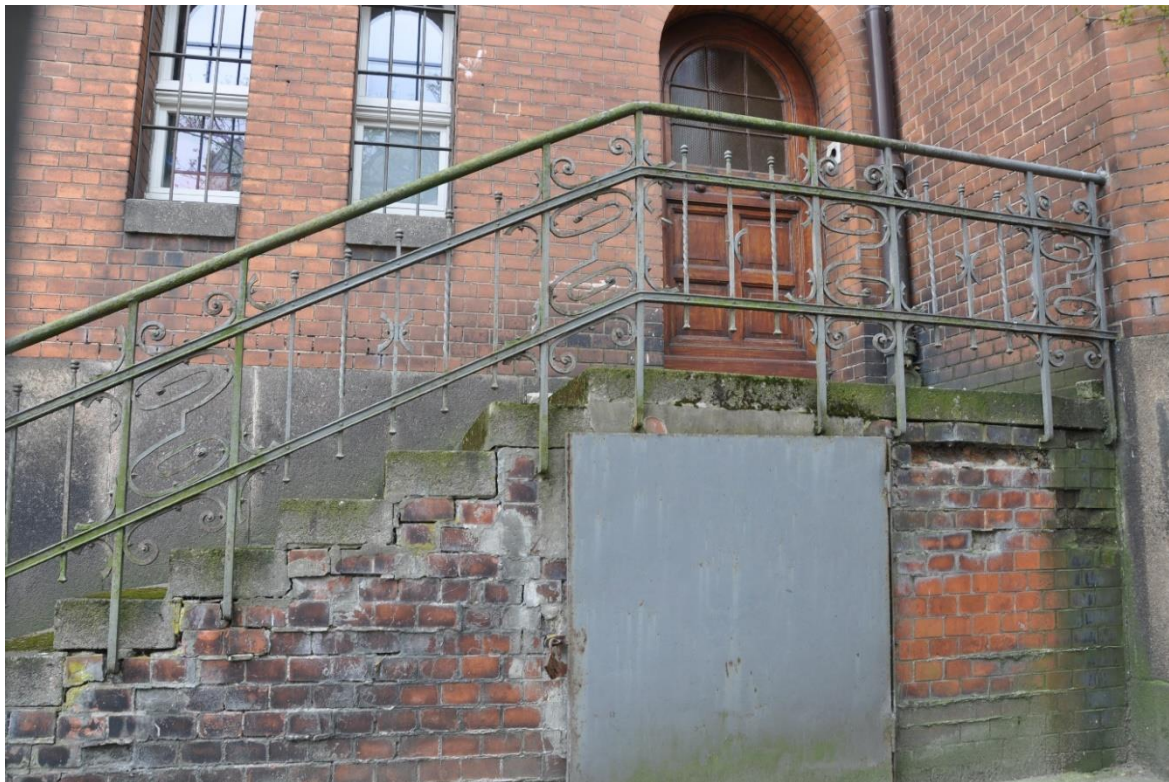
Fot. 58. Elewacja północno – zachodnia (od strony ul. Sikorskiego). Zły stan zachowania schodów.
