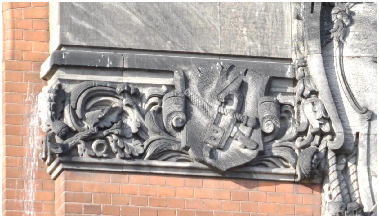
Fot. 37. Dekoracja na części centralnej elewacji frontowej: narzędzia stolarskie.
