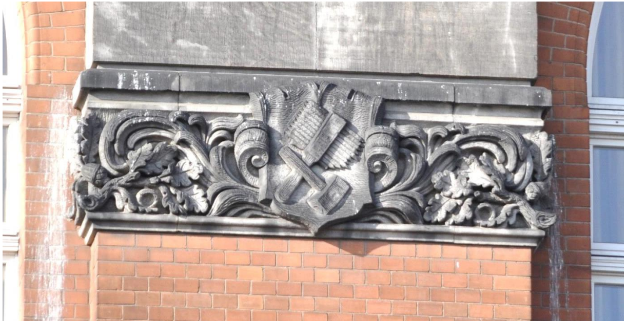
Fot. 36. Dekoracja na części centralnej elewacji frontowej: narzędzia kamieniarskie (w tym rodzaj dłuta: groszkownik z szeregiem ruchomych ostrzy, niem. Kenell).
