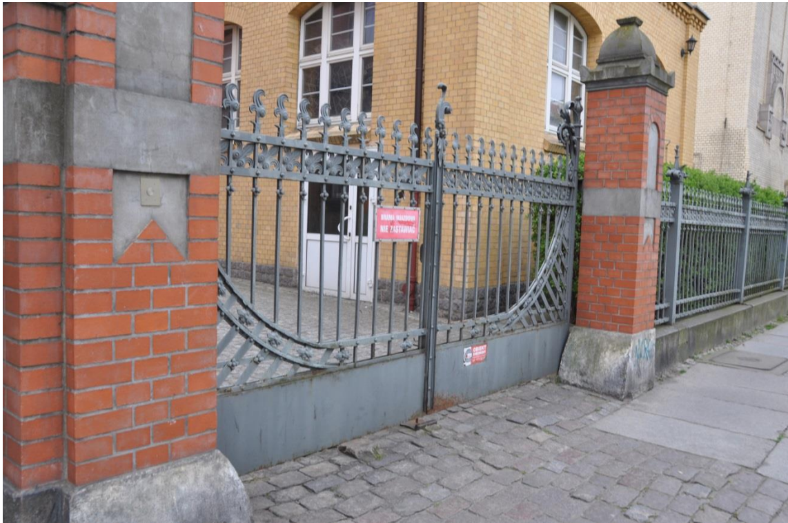
Fot. 60. Brama wjazdowa na teren podwórza budynku, od strony ulicy Sikorskiego.
