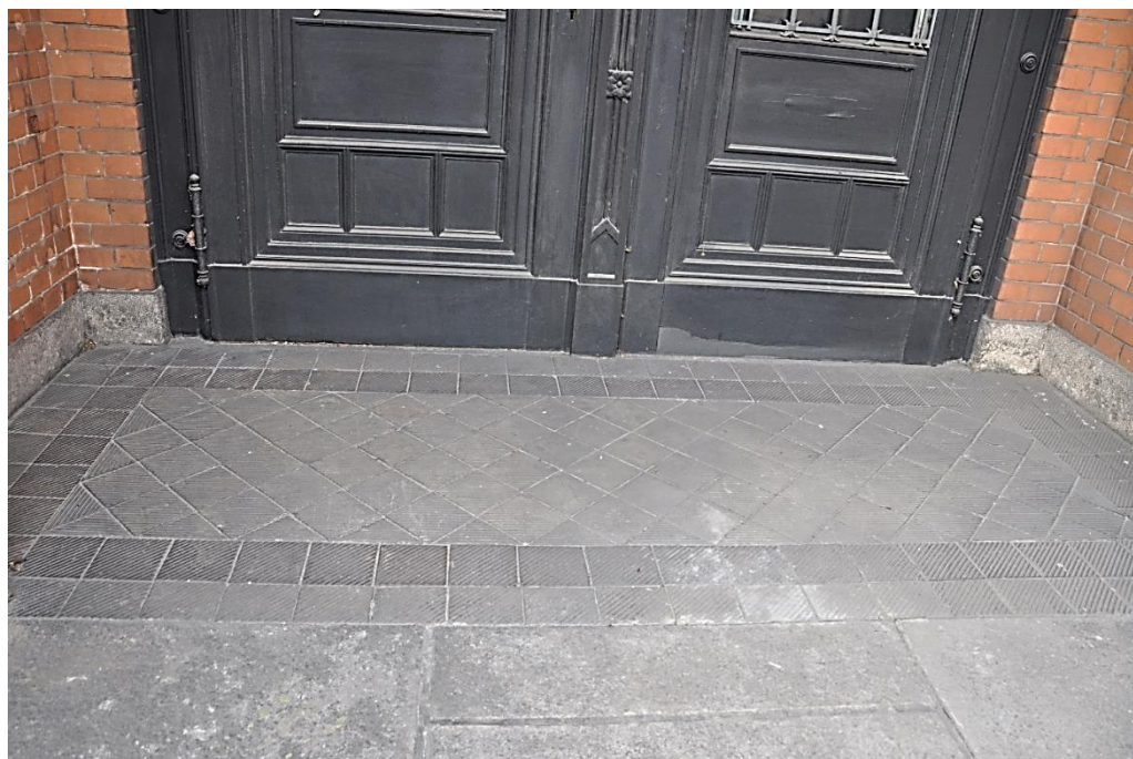
Fot. 63 Wejście do dawnej Królewskiej Szkoły Maszynistów Okrętowych, historyczna posadzka kamionkowa.
