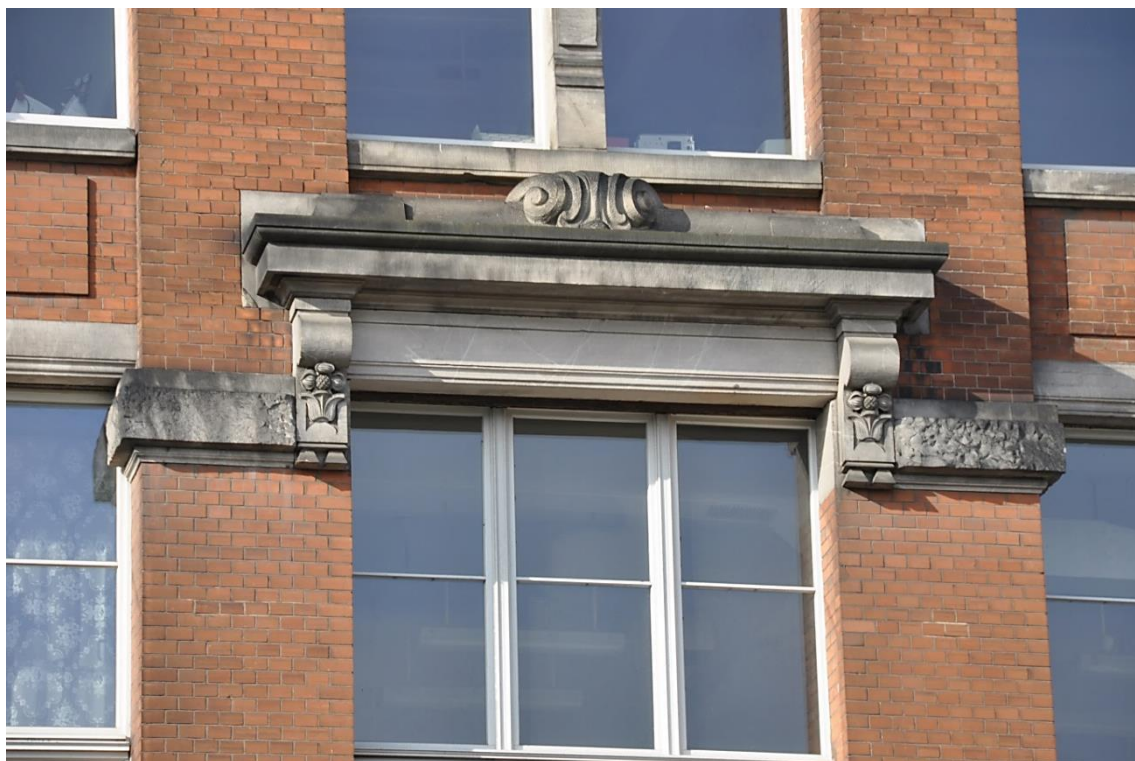
Fot. 43 Skromna dekoracja kamieniarska na słupkach okiennych i w nadprożach.
