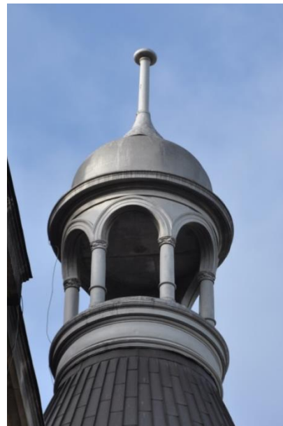
Fot. 22. Elewacja północno – zachodnia. Ozdobne kolumnienki, wykonane z blachy cynkowej, w galerijce na zwieńczeniu ryzalitu.
