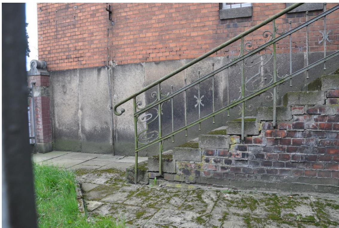
Fot. 59. Elewacja północno – zachodnia (od strony ul. Sikorskiego). Historyczna kuta balustrada.
