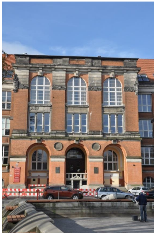
Fot. 2. Dawny budynek Królewskiej Szkoły Budowlanej (Königliche Baugewerkschule). Elewacja frontowa, północno-wschodnia. Stan zachowania w lutym 2020 r. Zmieniona forma dachu w środkowym ryzalicie.
