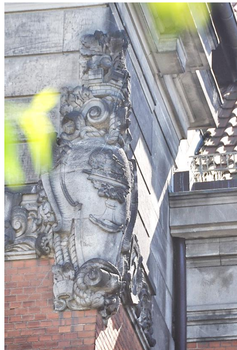
Fot. 29. Kartusz w narożniku ryzalitu na elewacji frontowej: herb Koszalina.
