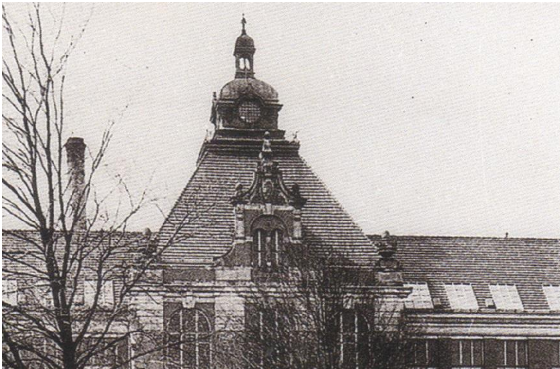
il. 5. Zbliżenie fragmentu zdjęcia z lat 1925-1930, pierwotny kształt dachu nad główną osią elewacji frontowej.
