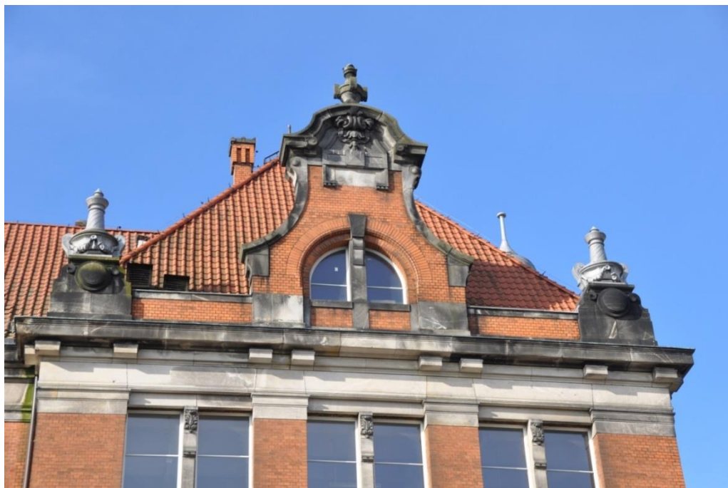
Fot. 17. Elewacja frontowa, północno-wschodnia, zwieńczenie ryzalitu północnego. Dekoracje wykonane z piaskowca i z blachy cynkowej.
