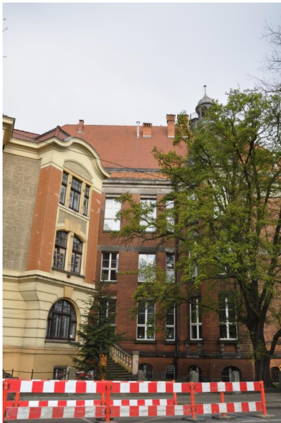
Fot. 8. Dawny budynek Królewskiej Szkoły Budowlanej (Königliche Baugewerkschule). Elewacja boczna, południowo-wschodnia. Stan zachowania w lutym 2020.
