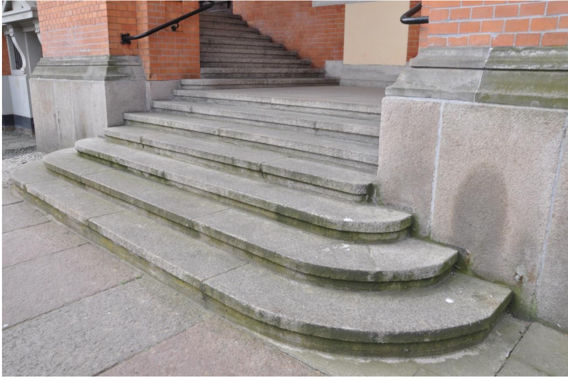
Fot. 49. Główne wejście do budynku, granitowe schody.
