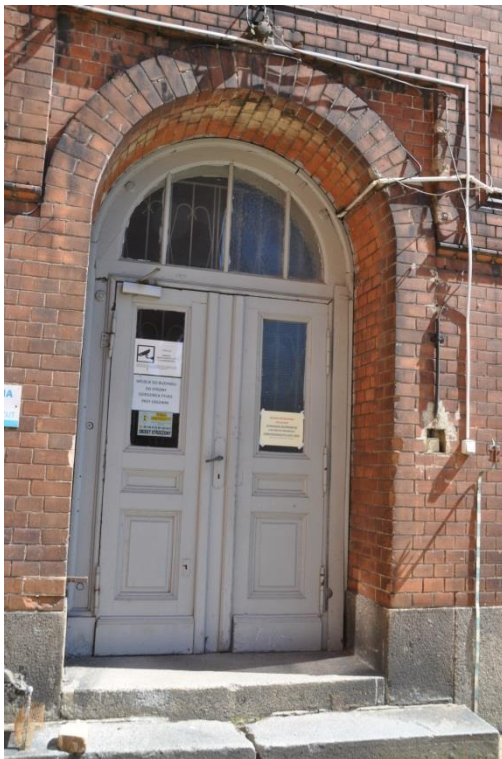
Fot. 68. Elewacja tylna: historyczna stolarka drzwiowa.
