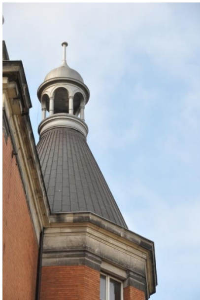
Fot. 21. Elewacja północno – zachodnia, boczna, zwieńczenie ryzalitu w formie stożkowego hełmu.
