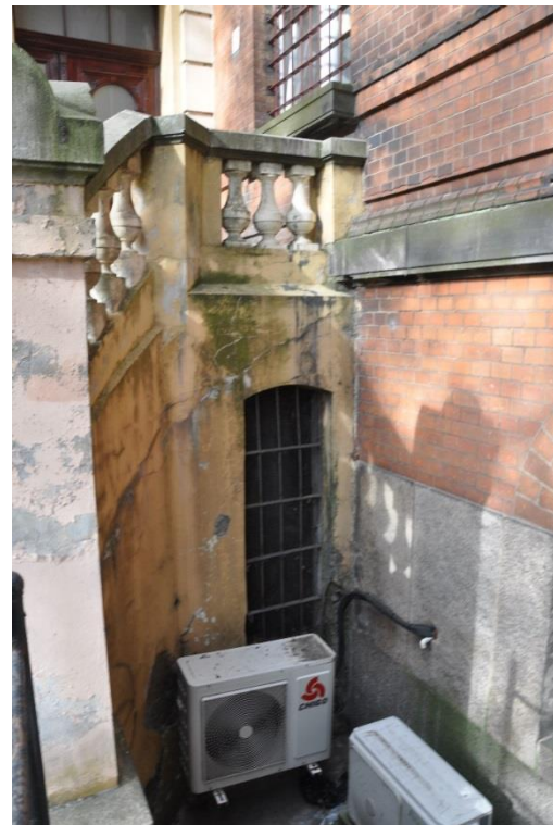
Fot. 55. Kanał wzdłuż elewacji południowo – wschodniej (od strony al. Piastów). Schody prowadzące do sąsiedniego budynku Rektoratu.
