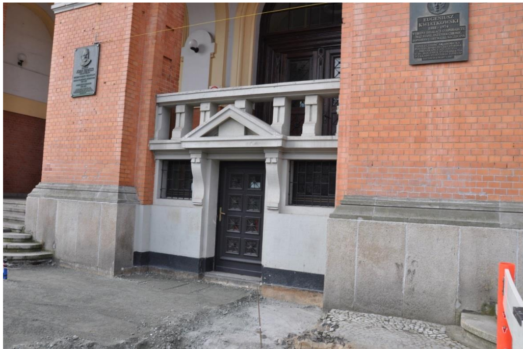
Fot. 50. Główne wejście do budynku. Stara portiernia.
