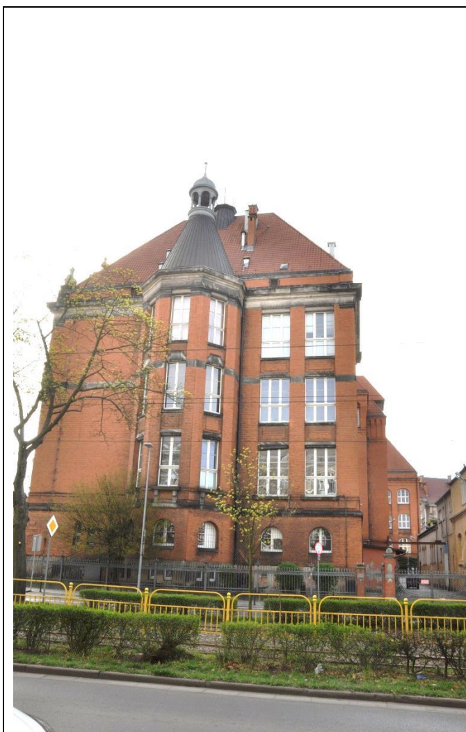
Fot. 6. Dawny budynek Królewskiej Szkoły Budowlanej (Königliche Baugewerkschule). Elewacja boczna, północno-zachodnia. Stan zachowania w lutym 2020 r.
