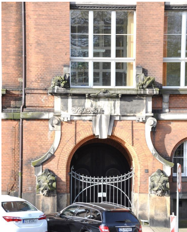
Fot. 23. Elewacja frontowa, wejście do budynku w ryzalicie od strony ul. Sikorskiego, dawne wejście do Królewskiej Szkoły Maszynistów Okrętowych.
