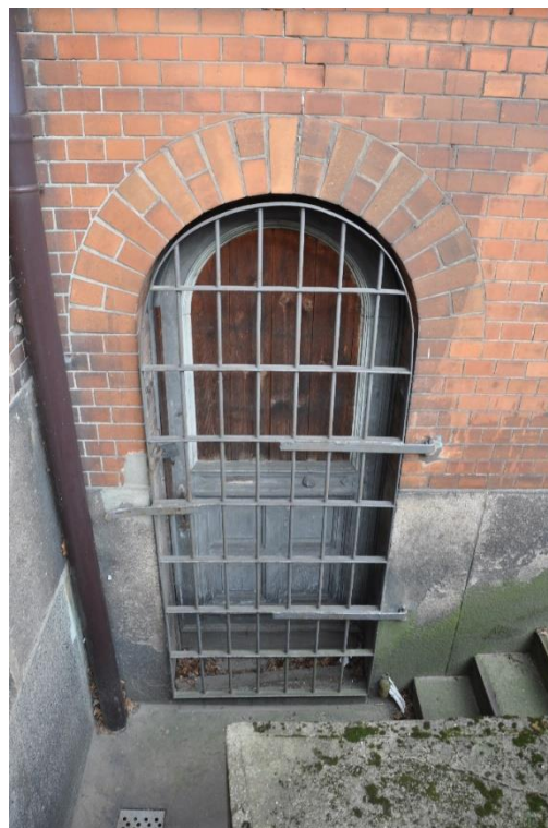
Fot. 57. Kanał wzdłuż elewacji południowo – wschodniej (od strony al. Piastów). Historyczna stolarka drzwiowa.
