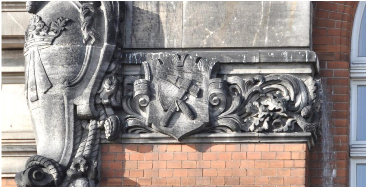
Fot. 34. Dekoracja na części centralnej elewacji frontowej: narzędzia murarskie.
