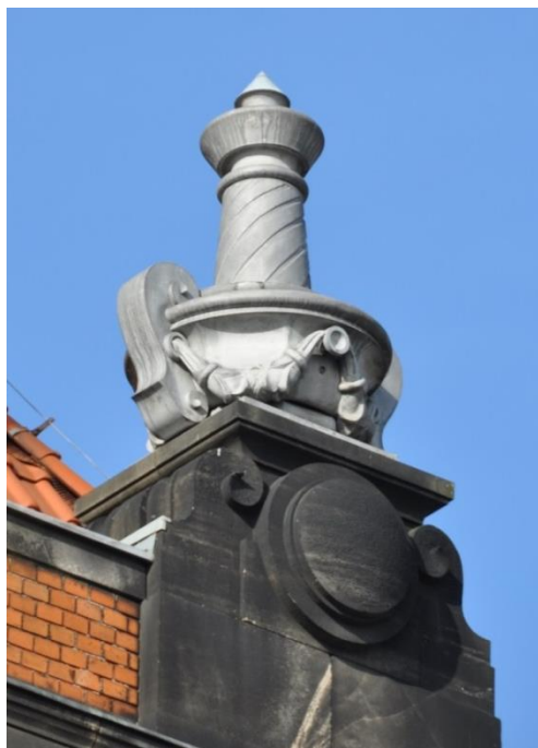
Fot. 19. Elewacja północno-wschodnia, zwieńczenie ryzalitu północnego, wykonane z blachy cynkowej
