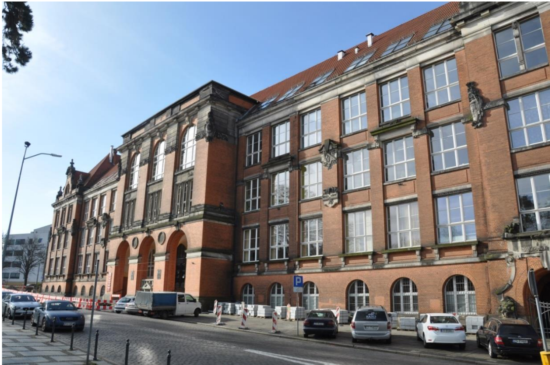
Fot. 4 Dawny budynek Królewskiej Szkoły Budowlanej (Königliche Baugewerkschule). Elewacja frontowa, północno-wschodnia. Stan zachowania w lutym 2020 r. Zmieniona forma dachu w środkowym ryzalicie.
