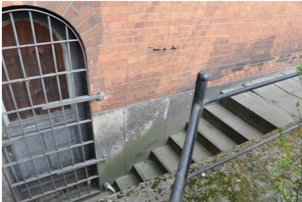
Fot. 56. Kanał wzdłuż elewacji południowo – wschodniej (od strony al. Piastów).
