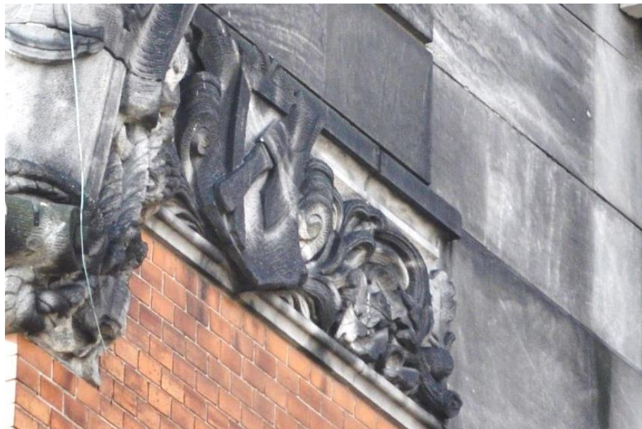
Fot. 38. Dekoracja na części centralnej elewacji frontowej: narzędzia ciesielskie.
