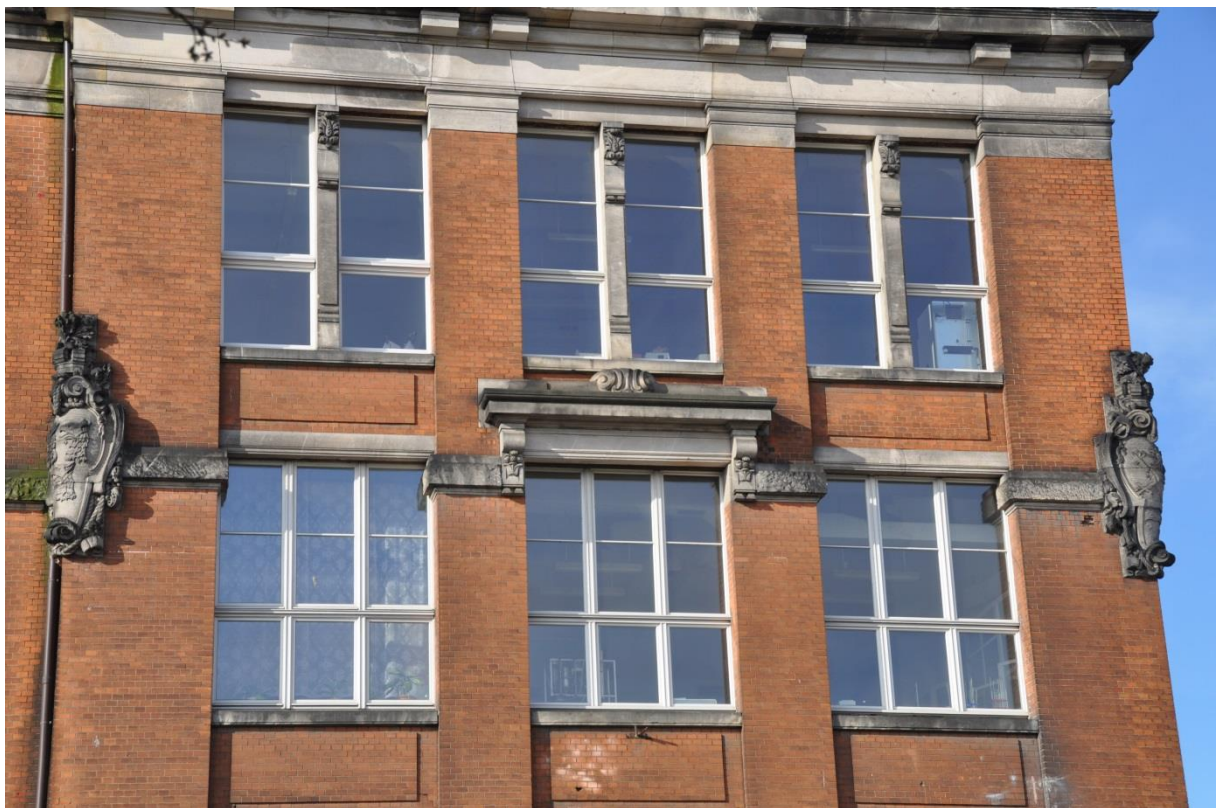
Fot. 42. Skromna dekoracja kamieniarska na słupkach okiennych i w nadprożach.
