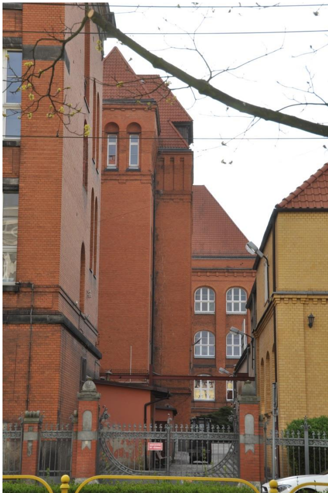
Fot. 11. Elewacja południowo – zachodnia, tylna. Ozdobna, historyczna brama wjazdowa.
