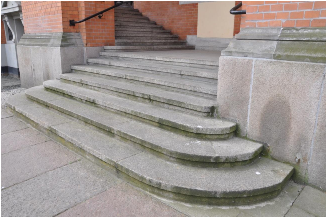
Fot. 49. Główne wejście do budynku, granitowe schody.
