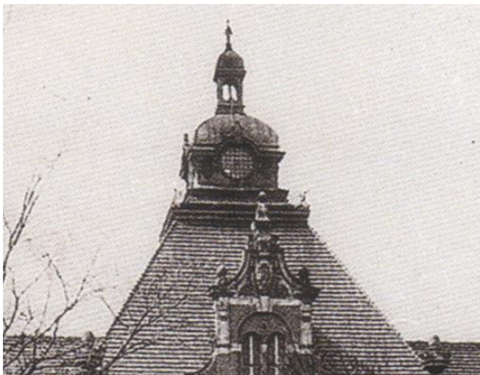
il. 6. Zbliżenie fragmentu zdjęcia z lat 1925-1930, widoczne okrągłe okienko w zwieńczeniu dachu.
