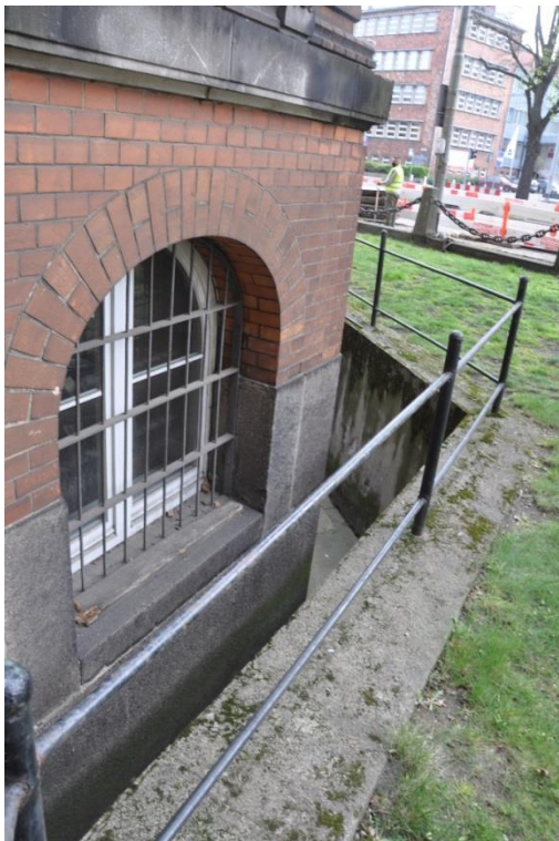
Fot. 54. Kanał wzdłuż elewacji południowo – wschodniej (od strony al. Piastów).
