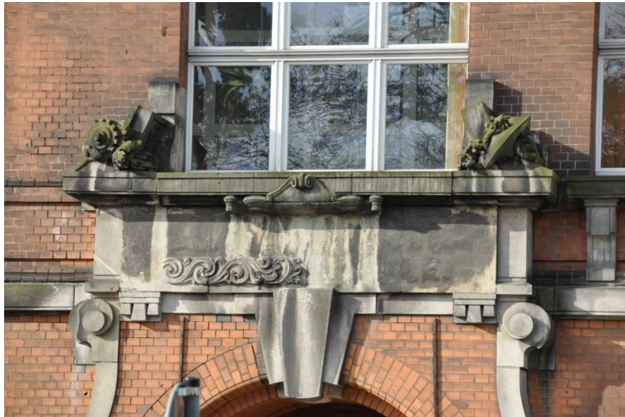
Fot. 25. Elewacja frontowa, wejście do budynku w ryzalicie od strony ul. Sikorskiego, dawne wejście do Królewskiej Szkoły Maszynistów Okrętowych. Kamienne detale (kotwica i koło zębate) nawiązujące do kierunku kształcenia.
