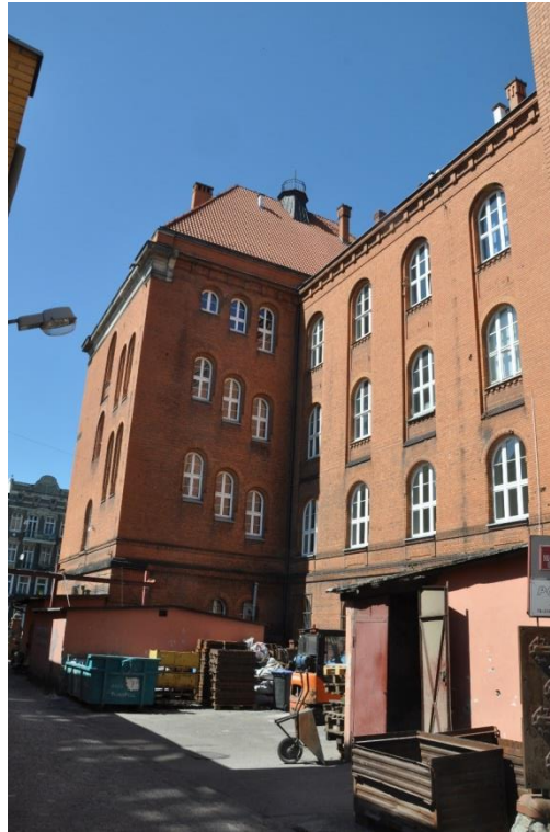
Fot. 16. Elewacja południowo – zachodnia, tylna. Skrzydło od strony północnej.
