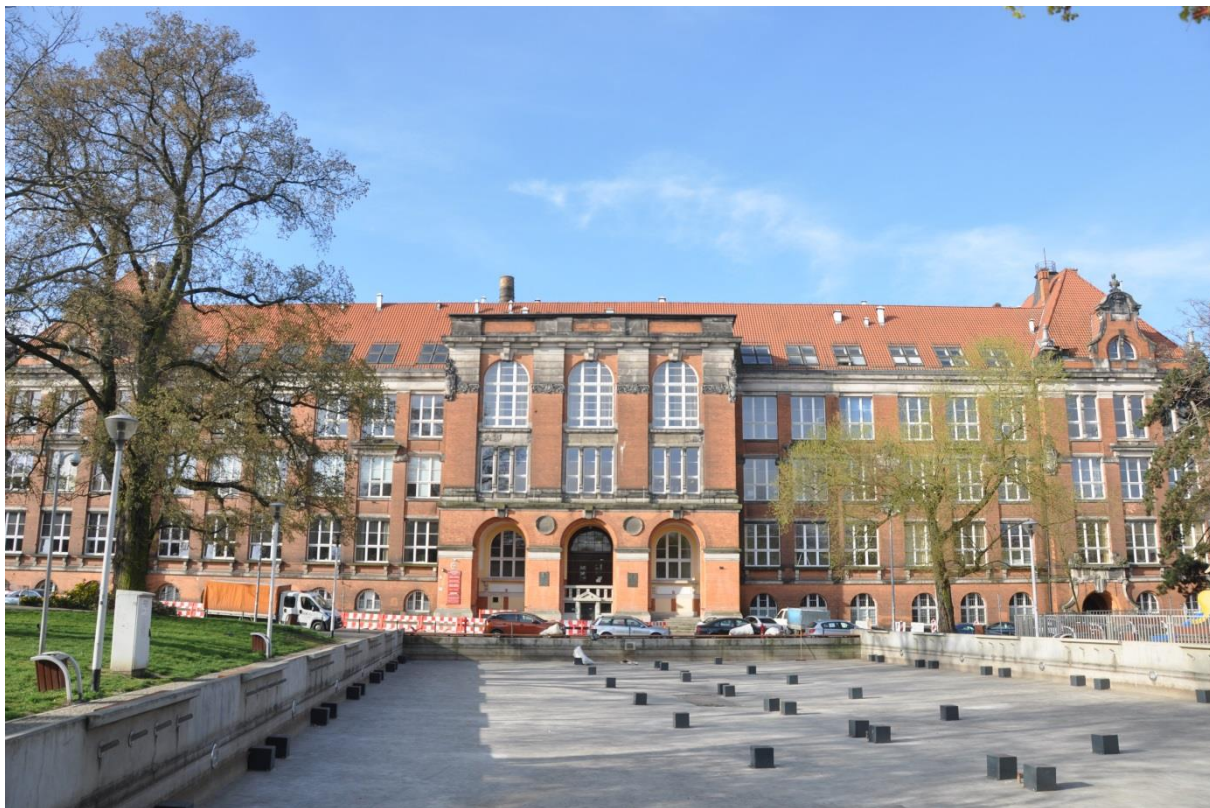
Fot. 1. Dawny budynek Królewskiej Szkoły Budowlanej (Königliche Baugewerkschule). Elewacja frontowa, północno-wschodnia. Stan zachowania w lutym 2020 r. Zmieniona forma dachu w środkowym ryzalicie.
