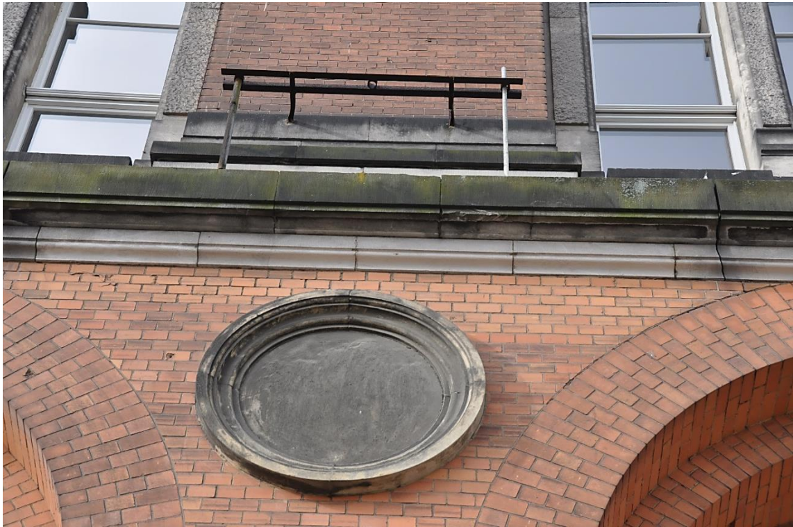
Fot. 47. Tondo na elewacji frontowej. Pierwotnie tło było wypełnione płaskorzeźbą lub napisem.
