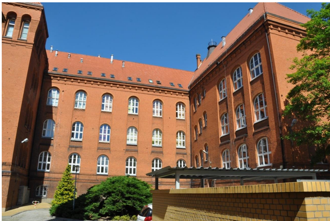
Fot. 14 Elewacja południowo – zachodnia, tylna. Skrzydło od strony południowej.
