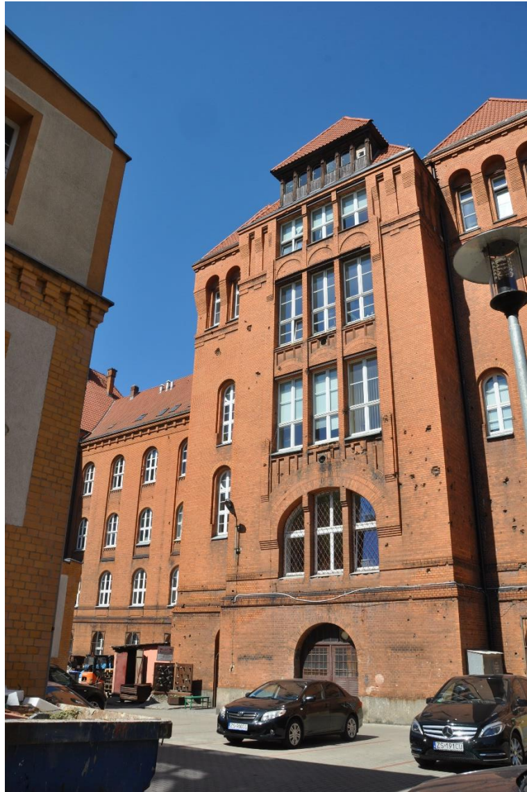
Fot. 13 Elewacja południowo – zachodnia, tylna. Oś centralna budynku, mieszcząca klatkę schodową.
