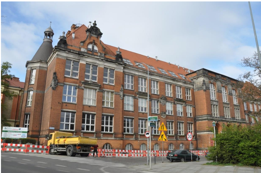
Fot. 5 Dawny budynek Królewskiej Szkoły Budowlanej (Königliche Baugewerkschule). Elewacja frontowa, północno-wschodnia. Stan zachowania w lutym 2020 r. Zmieniona forma dachu w środkowym ryzalicie.
