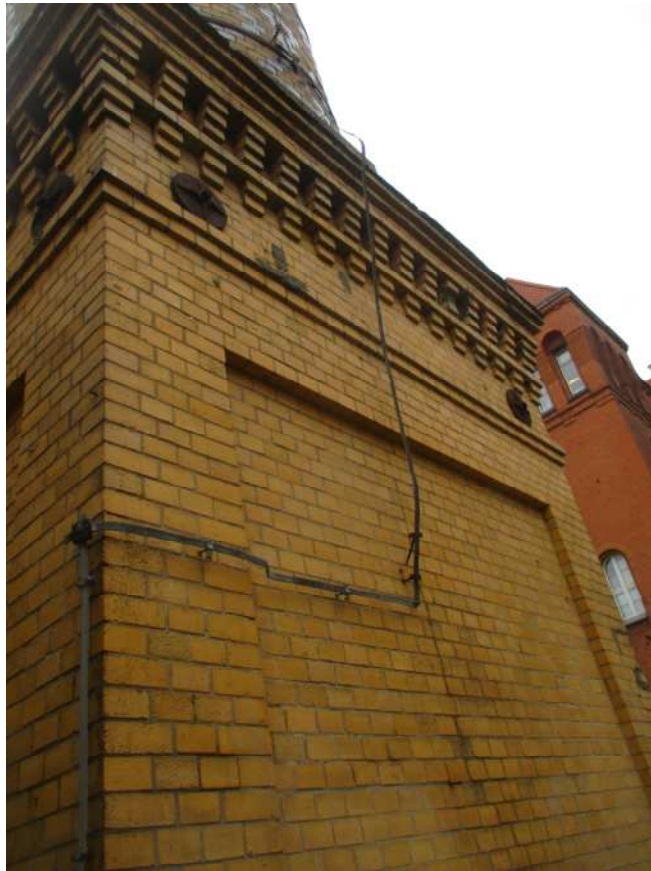
Fot.36.Instalacja odgromowa
