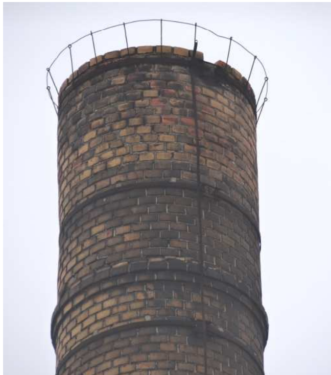
Fot.24.Szczytowy odcinek trzonu komina
