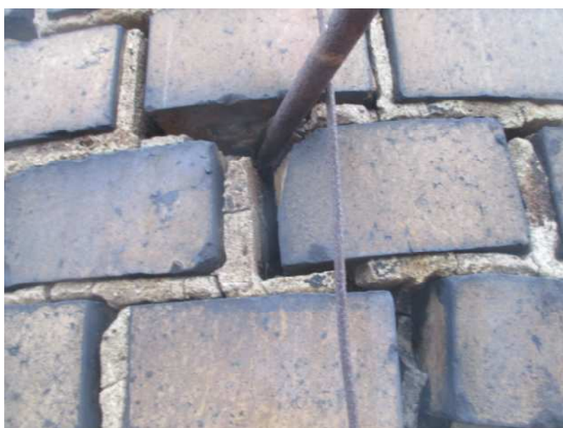
Fot.20.Poluzowany szczelbel włazowy
