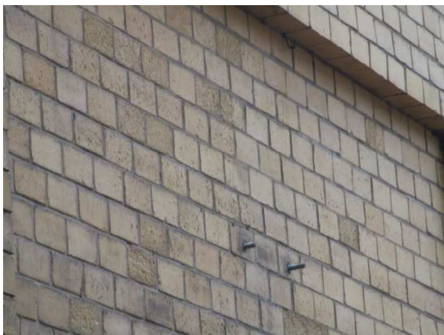
Fot.39. Pozostawione kotwy po zdemontowanych konstrukcjach wsporczych elementów stacji bazowej sieci T-Mobile
