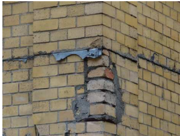
Fot.4.Slady po dachu zdemontowanego pomieszczenia
