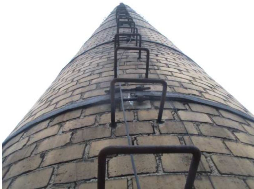
Fot.7.Trzon pierścieniowy komina, ciąg szczebli włazowych
