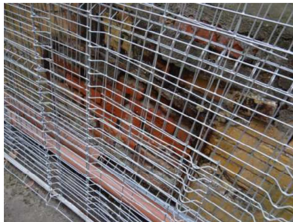
Fot.5.Zamurowany otwór wyczystkowy
