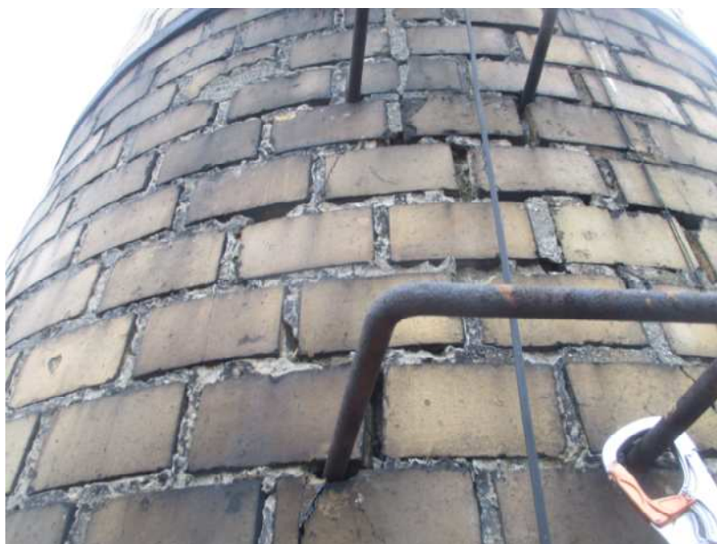
Fot.19.Poluzowany szczelbel włazowy
