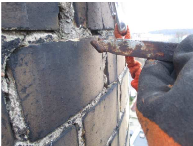
Fot.18.Wysuwający się szczelbel włazowy
