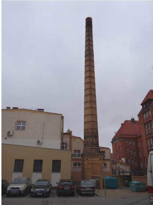
Fot.1. Widok ogólny komina
