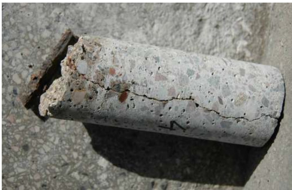
Fot. 21. Próbkę nr 4: pęknięcie przez całą wysokość; w dolnej części beton zawilgocony
