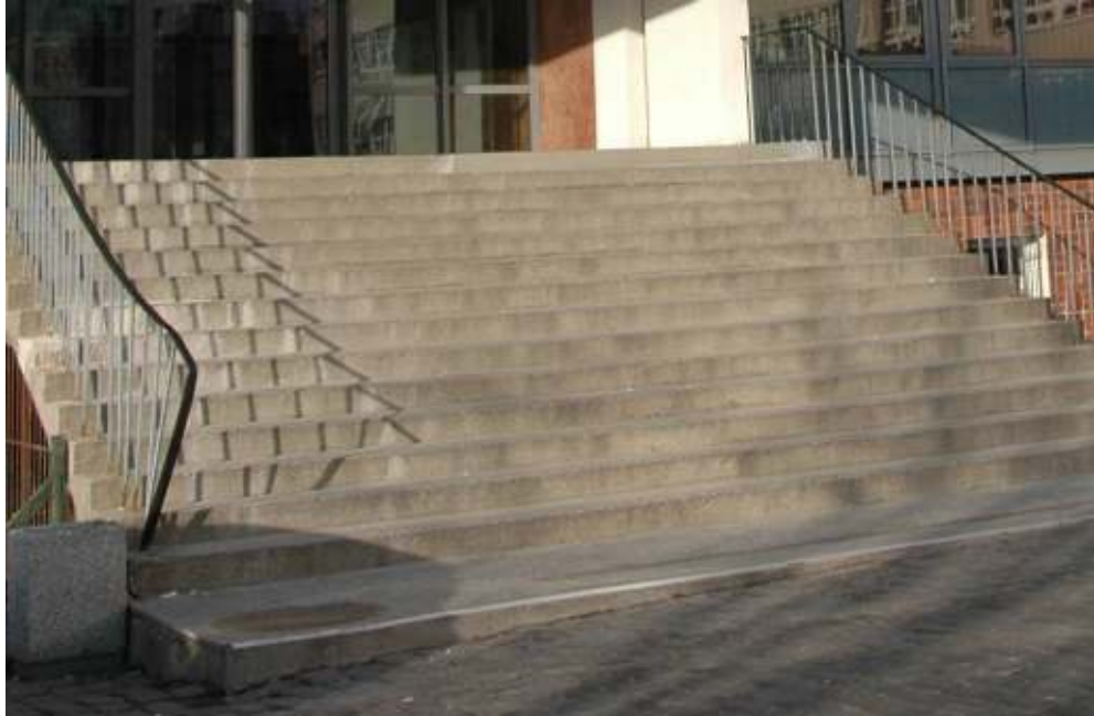
Fot. 26. Fragment biegu schodów: podest dolny w świetle pasa jezdni.
