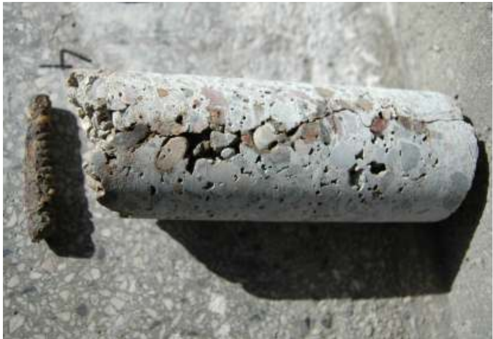
Fot. 22: Próbkę nr 4: pęknięcie przez całą wysokość; beton porowaty; zbrojenie skorodowane;
