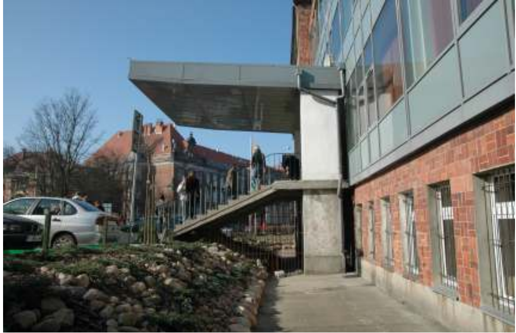
Fot. 2: Widok boczny schodów wejściowych.
