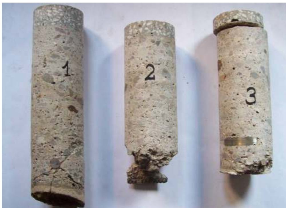
Fot. 33. Próbki pobrane z konstrukcji schodów: beton od góry jest zagęszczony; od dołu jest porowaty o obniżonej wytrzymałości;
