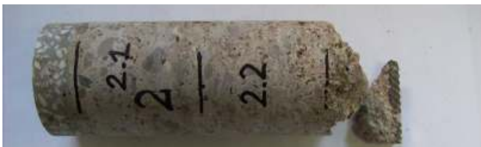
Fot. 35. Odwiert nr 2 o średnicy \varnothing 94 mm: beton od góry jest zagęszczony; od dołu jest porowaty o obniżonej wytrzymałości;
